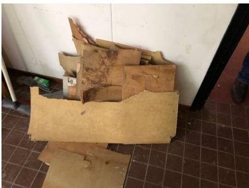
Foto 5: verwijderde asbesthoudende vloermaterialen in de ruimte van het kruipluik
