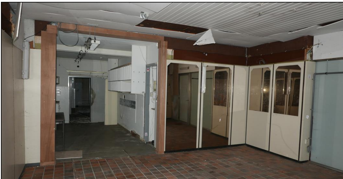
De winkelruimte, gezien naar het westen.
