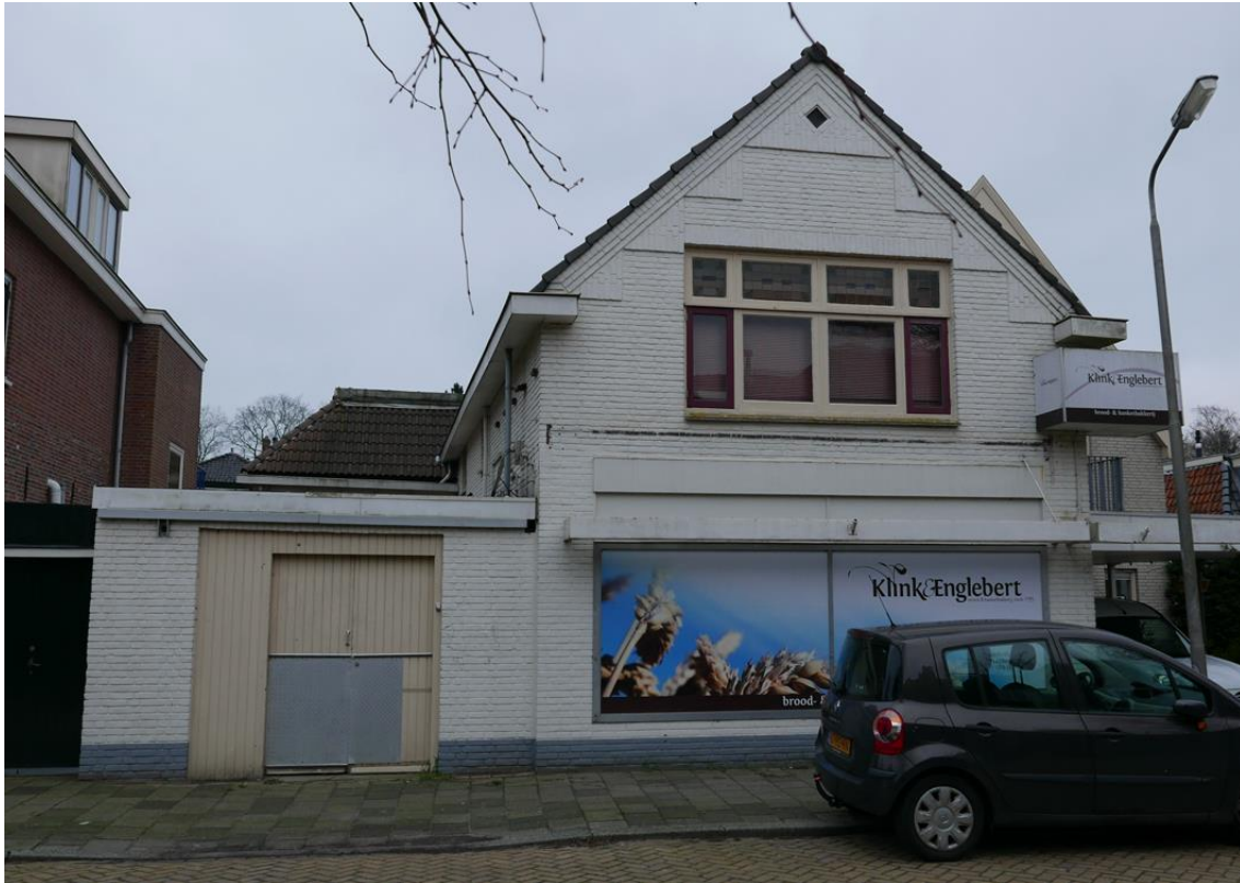
De gevel uit 1930 aan de straat, met bijbehorende garage en winkelpui uit 1961.
