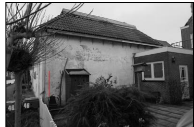
De zuidgevel van het bouwdeel aan de Rijn. Rood is de verticale naad gemarkeerd.
