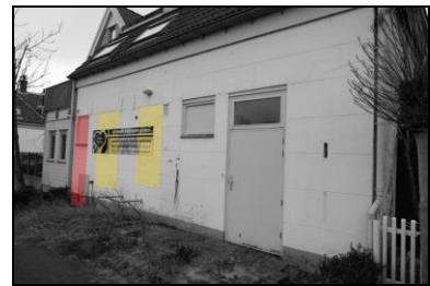
De westgevel van het bouwdeel aan de Rijn. Geel zijn twee dichtgemetselde vensters aangegeven en rood de aangepaste toegang die zelf waarschijnlijk pas in 1930 is gemaakt.
