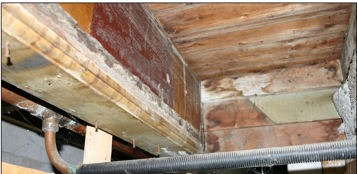
Foto naar het oosten met de aftekening van de trapboom en sporing voor een houten wand eronder op een plank, haakst tegen de noordelijke balk waarop een imitatie traploper is geschilderd.
