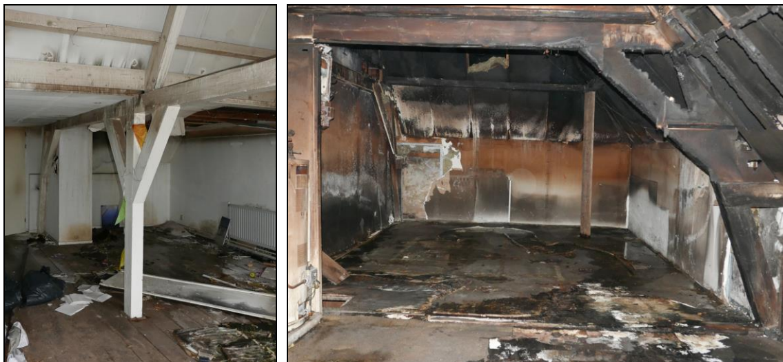
Het van oorsprong middelste spant op de noordelijke zolder, gezien naar het zuidoosten (links) en het hafspannt op de zuidelijke zolder, gezien naar het oosten (rechts).
