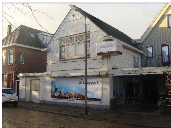
Foto 1. Pand gezien vanaf de Hoofdstraat
