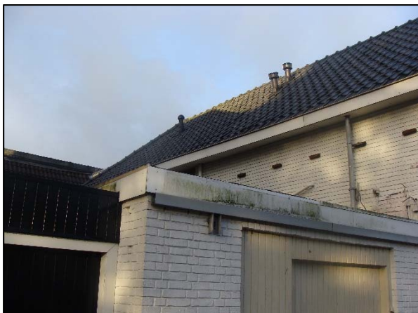
Foto 3. Dak van het pand
