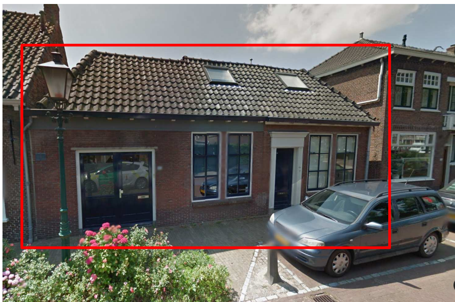
Bestaande situatie Hoofdstraat 158 te Leiderdorp
