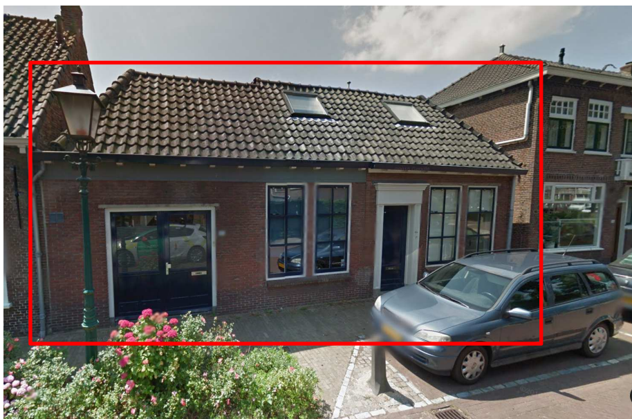
Bestaande situatie Hoofdstraat 158 te Leiderdorp
