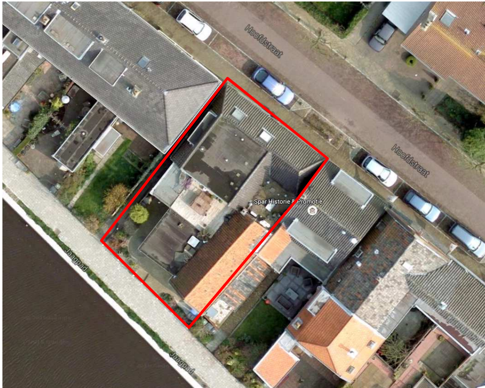
Bestaande situatie Hoofdstraat 158 te Leiderdorp
