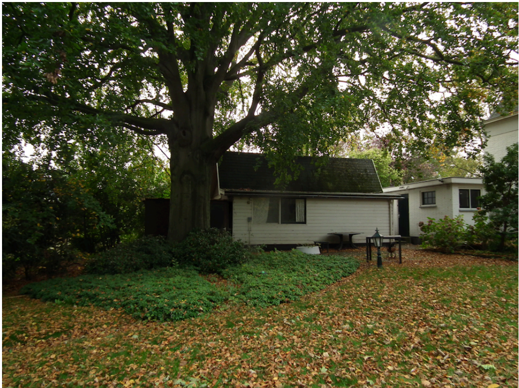
Figuur 2 Het vrijstaande bijgebouw en de aangebouwde garage worden gesloopt ten behoeve van een te realiseren appartementencomplex.
