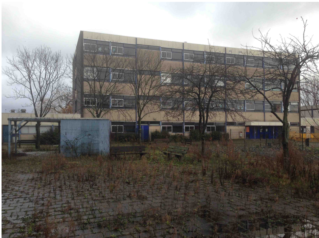
Figuur 2 De beoogde ingreep bestaat uit de sloop van alle gebouwen ten behoeve van de nieuwbouw van diverse typen woningen.
