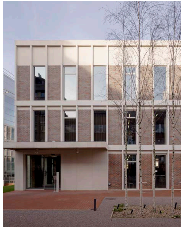
Hoofdentree als verbijzondering op het complex en in de openbare ruimte | Morris Duggan, Londen
