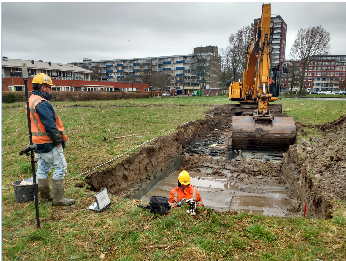
Figuur 3. Aanleg van de proefsleuf.
