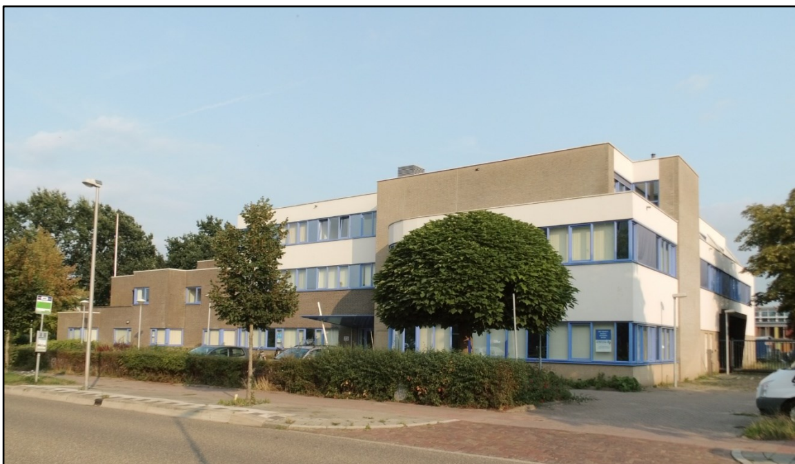
Afbeelding: het bestaande kantoorpand aan de Hoogmadeseweg 72 te Leiderdorp.
