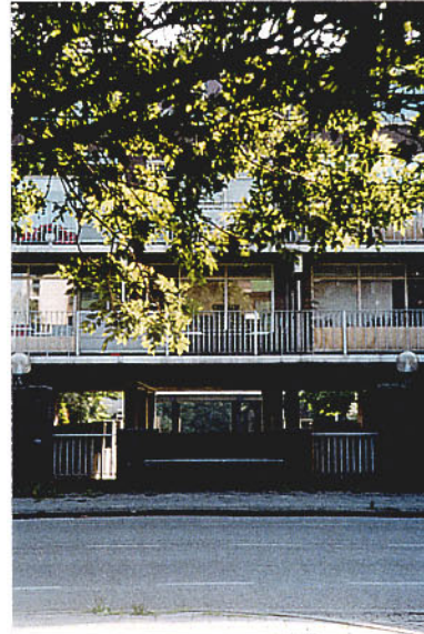
Onderdoorgangen en overbouwde singels
