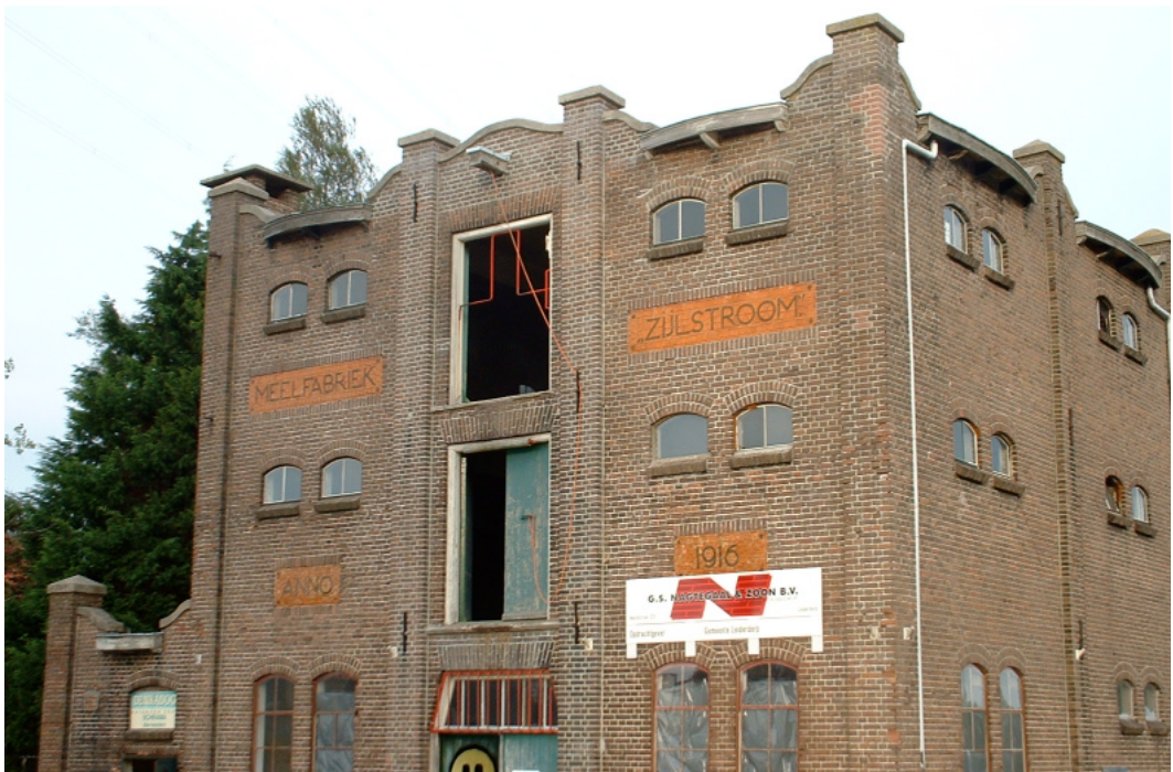
Historische meelfabriek Zijlstream
